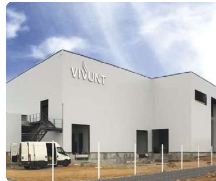
Obras de la fábrica en Villadangos del Páramo (León).
